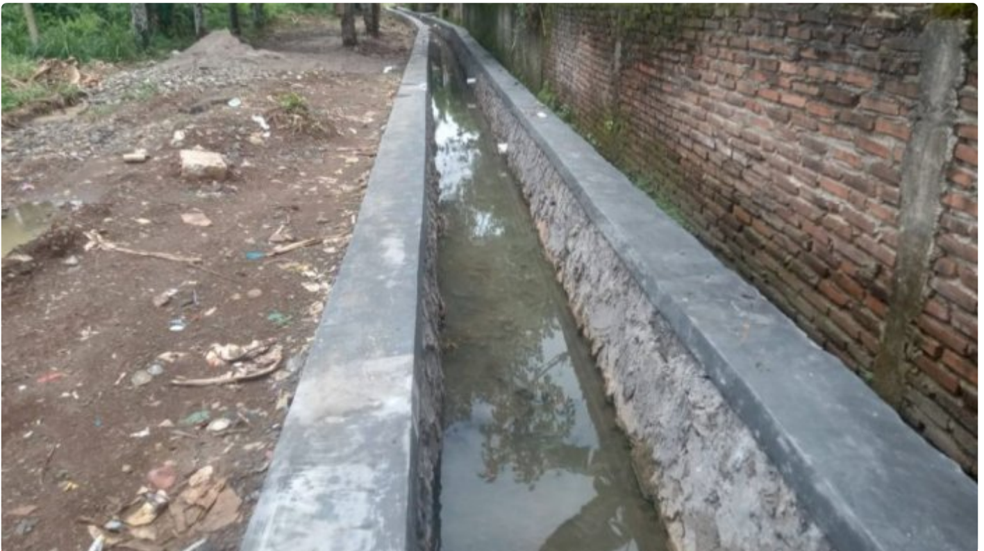
Pembangunan Saluran Drainase di Desa Sukamaju Kecamatan Labuan Tepatnya di Perumahan Griya Asri Labuan
